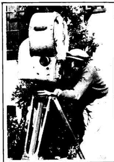
LA CAMARA DEL CINE HABLADO.—Bell & Howell, los famosos constructores de cámaras cinematográficas a base de $5,000 cada una, acaban de lanzar esta cámara especial para el cine hablado. La gigantesca envoltura exterior es absolutamente impermeable al sonido, gracias a lo cual pueden obtenerse fonogramas de una pureza extraordinaria. (Fotos Underwood & Underwood).
