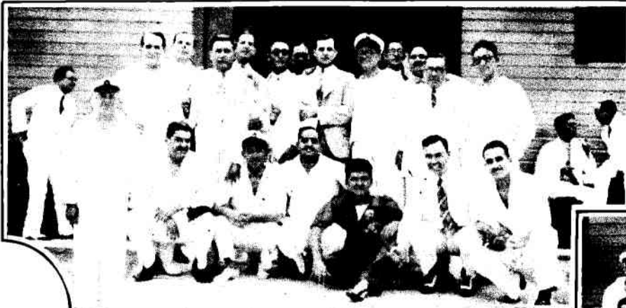
He aquí los felices constructores de la flamante casa de botes del Miramar. Todos sonrien satisfechos de su obra. El mordaz Paul Morand lapidó a los deportes como "la revancha del trabajo sobre los ociosos". ¿Qué diría, ahora, el escritor francés después de ver la obra de nuestros sportsmen?
