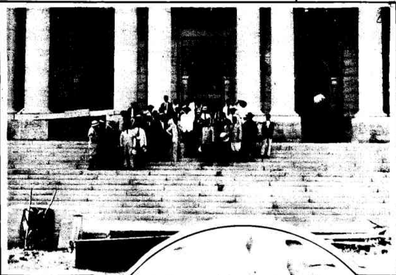
El Doctor Carlos Miguel de CESPEDES y los excursionistas visitando las obras del Palacio de Justicia de Santa Clara.
